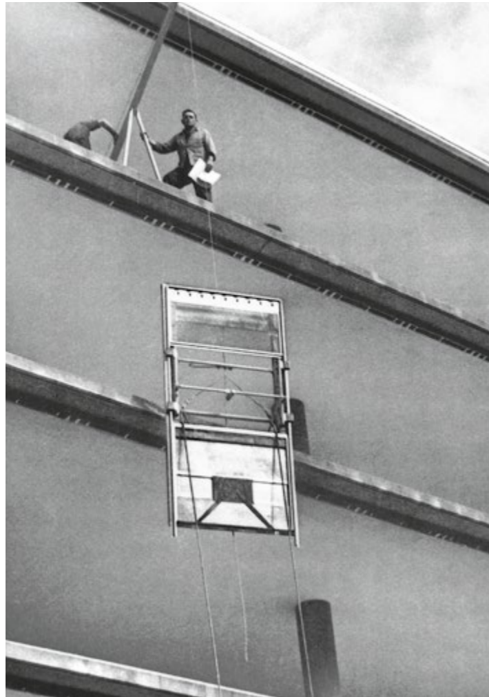
SIÈGE DE LA FÉDÉRATION NATIONALE DU BÂTIMENT, PARIS - MONTAGE DES PANNEAUX DE FAÇADE, 1949.
